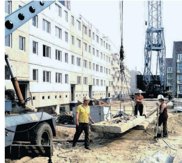
**Einheitliche Plattenraster** und vorgefertigte Betonteile machten den Neubau mit WBS 70 schnell und günstig. Foto: dpa Picture-Alliance/Benno Bartscha
