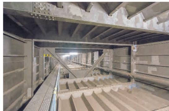
**Im Brückenkasten:** Solche Hohlstrukturen bilden den Brückenkörper. Das Bild zeigt das Innere der alten Brücke. Foto: Ulrich Zillmann
