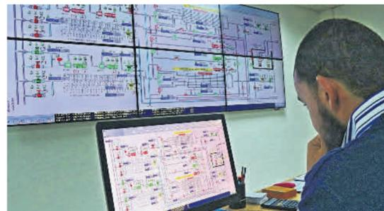
**Im Kontrollraum** werden Temperatur und Salzgehalt ständig überprüft. Die Grafiken auf den Monitoren zeigen dies in Echtzeit. Foto: Oliver Ristau
