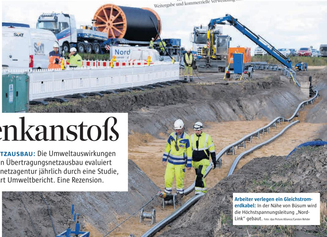
Arbeiter verlegen ein Gleichstromkabel: In der Nähe von Büsum wird die Höchstspannungsleitung „Nord-Link“ gebaut. Foto: dpa Picture Alliance/Carsten Rehder
