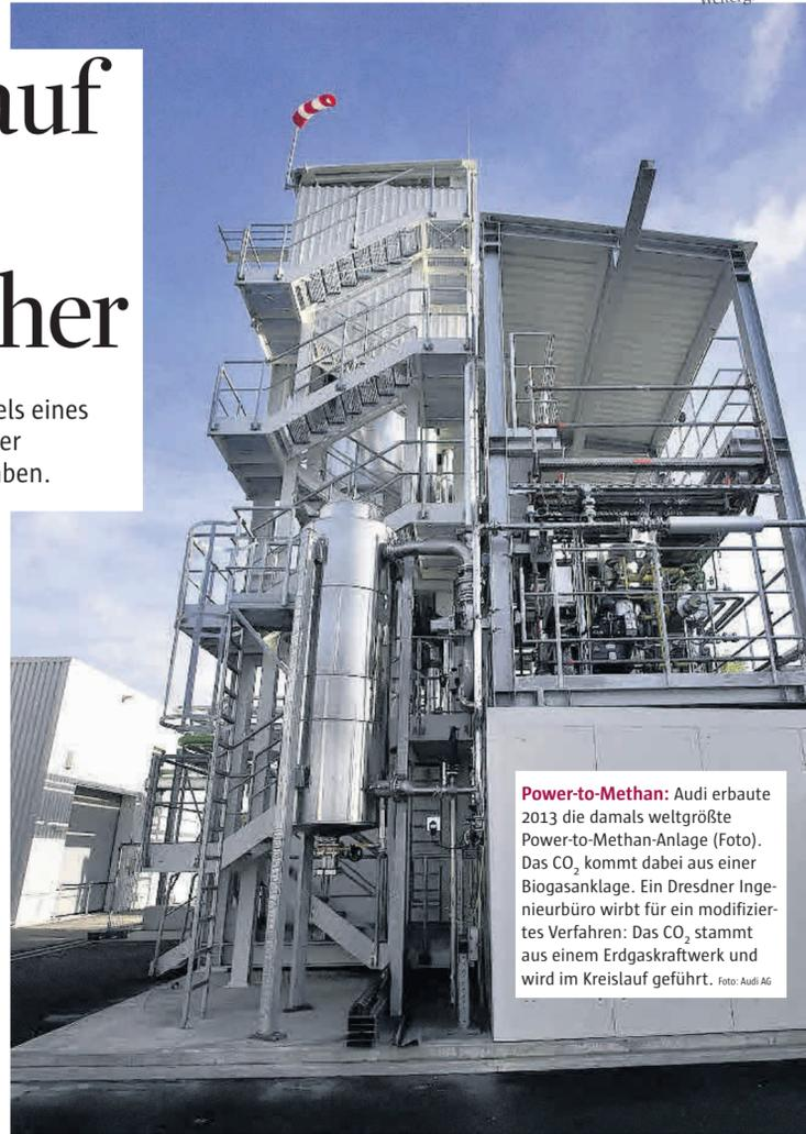
**Power-to-Methan:** Audi erbaute 2013 die damals weltgrößte Power-to-Methan-Anlage (Foto). Das CO<sub>2</sub> kommt dabei aus einer Biogasanlage. Ein Dresdner Ingenieurbüro wirbt für ein modifiziertes Verfahren: Das CO<sub>2</sub> stammt aus einem Erdgaskraftwerk und wird im Kreislauf geführt. Foto: Audi AG
