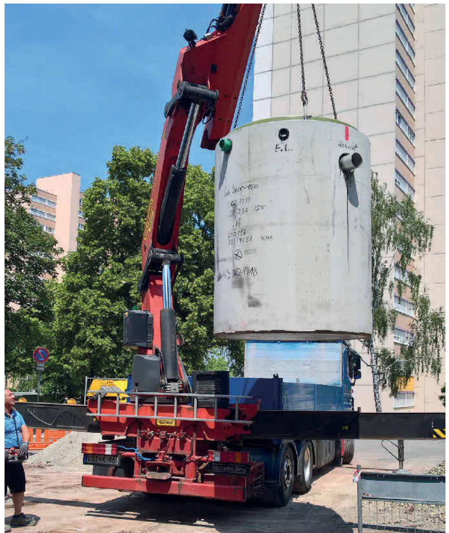
Bild 1 Vom LKW in die Baugrube. Sicherheitsauffangbecken bilden die Schutzkulissee rund um Böblingens BHKWs. Foto: Mall
