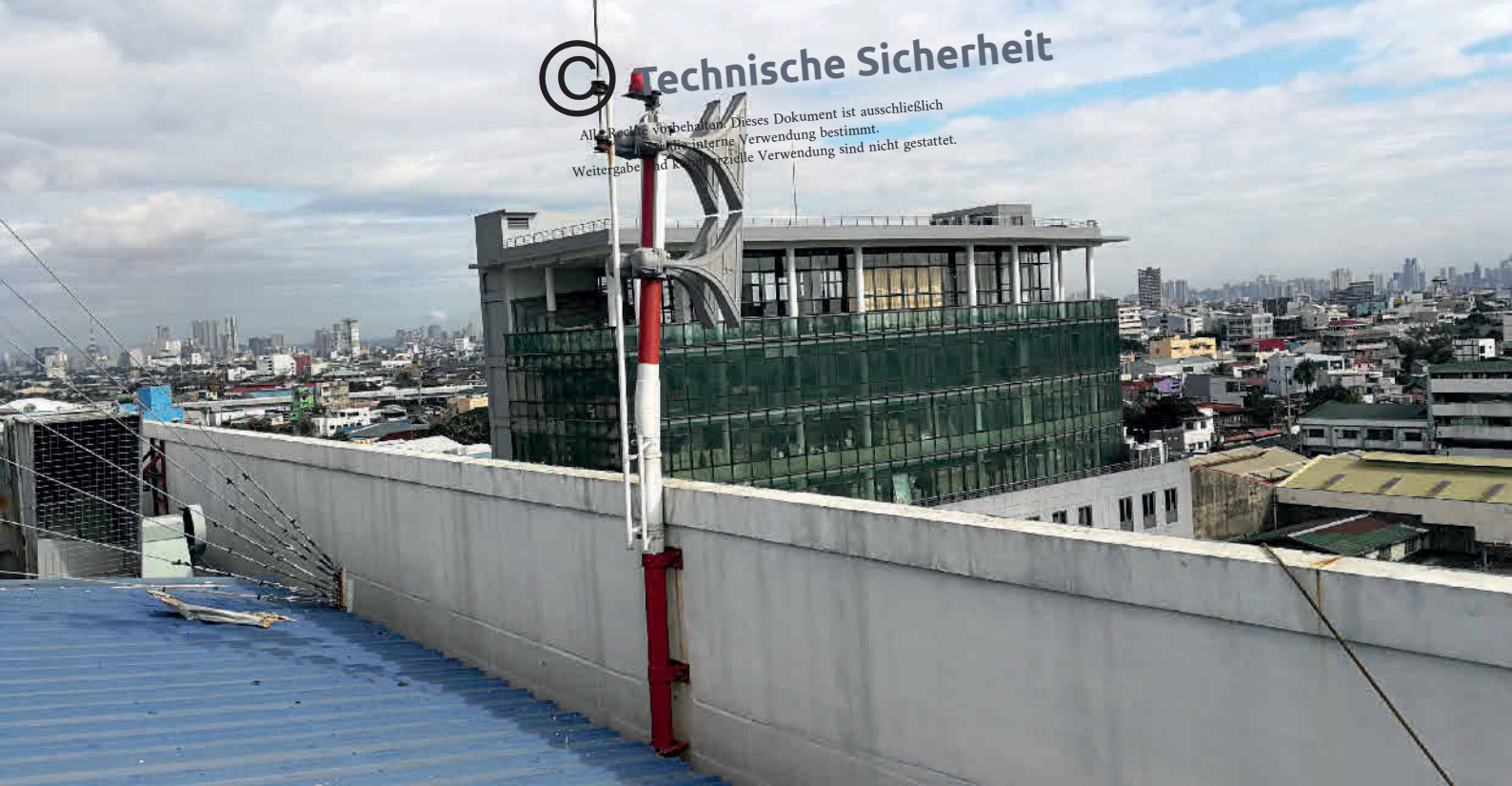
Sirenen zur Bevölkerungswarnung vor Erdbeben. (Projekt für die Stadtverwaltung in Manila/ Philippinen). Foto: Secty electronics
