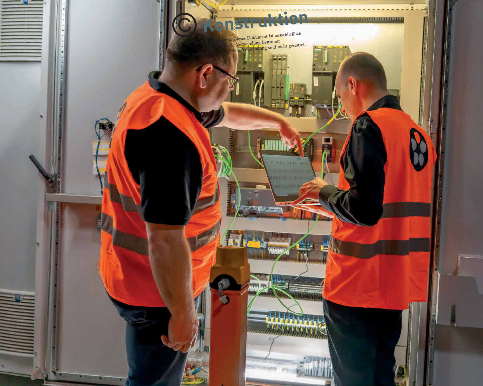
Bild 1: Beim Network Approval Service prüfen Expert:innen von Lapp die „Nervenbahnen“ der Maschine. Foto: Lapp
