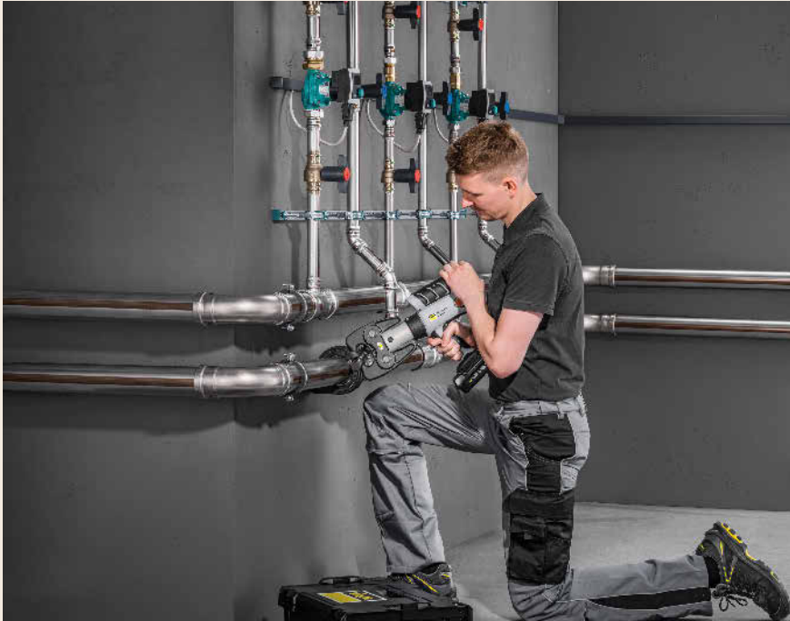
Bild 5 Für Trinkwasserversorgungsnetze gelten Rohre aus nichtrostendem Duplex-Edelstahl als besonders nachhaltige und leckagesichere Lösung. Foto: Viega
