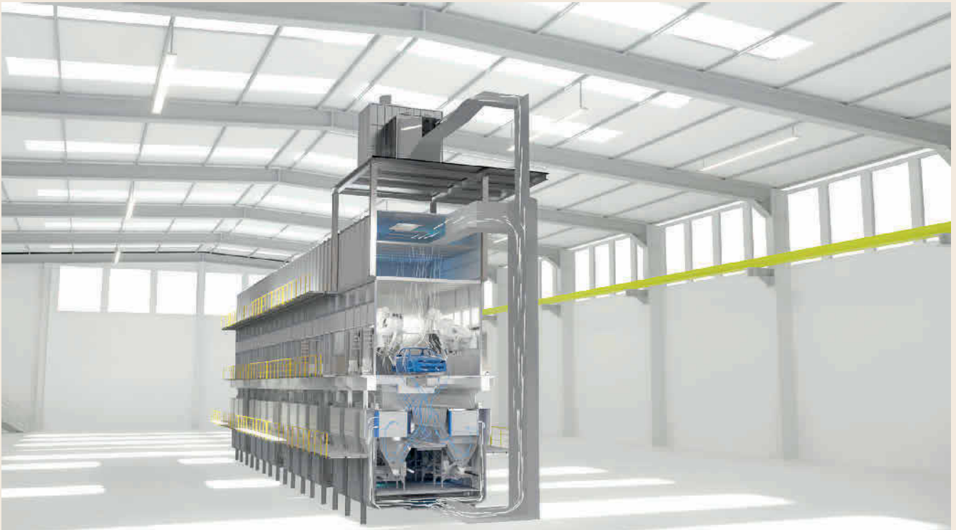
Bild 2 Die Trockenabscheidung Eco Dry Scrubber spart 60 Prozent Energie und steht für besonders nachhaltiges Lackieren. Foto: Dürr
