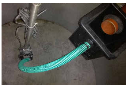
Ein Speicher zur gedrosselten Ableitung oberhalb der Rückstauenebene ist ein Element des kommunalen Starkregen-Risikomanagements. Die Pumpe „Jano T“ von Mall entleert nach jedem Regenereignis das Rückhaltevolumen oben. Das Nutzvolumen unten wird davon unabhängig vom Regencenter im Gebäude gefördert. Foto: Mall
