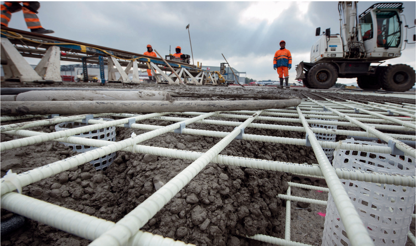
Glasfaserverbundbewehrung ist besonders bei korrosionsgefährdeten, nichttragenden Bodenplatten wirtschaftlich. Foto: Thomas Entzeroth
