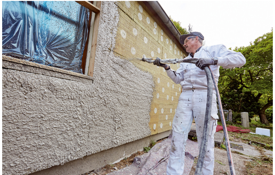
Mineralischer Grundputz und Gewebe sorgen dafür, dass die Putzschicht beim Rückbau von der Dämmplatte getrennt werden kann. Foto: Saint-Gobain Weber
