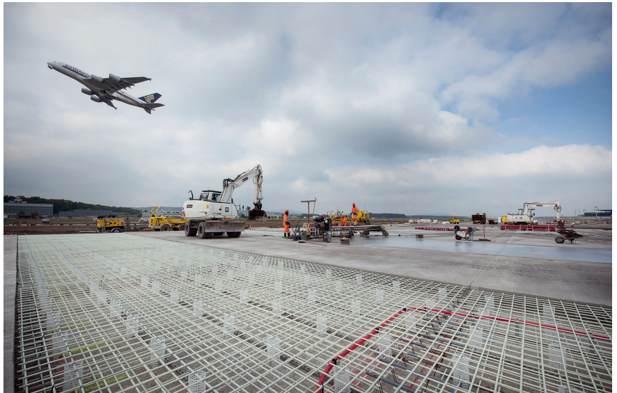
Das Rollfeld des Flughafens in Zürich wurde mit Combar® bewehrt – für eine störungsfreie Kommunikation des Sicherheitssystems. Foto: Thomas Entzeroth
