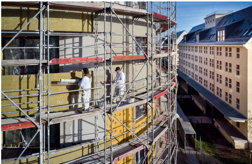
Mehrere Quartiere wurden bereits mit dem innovativen WDVSystem errichtet, darunter das Speicherballt der Buwog in Berlin-Spandau. Foto: Saint-Gobain Weber
