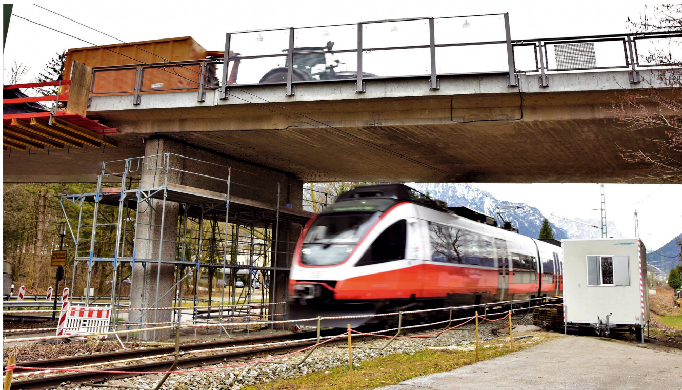
Die Brücke in Bad Reichenhall konnte bei laufendem Verkehr verstärkt werden. Foto: Würth
