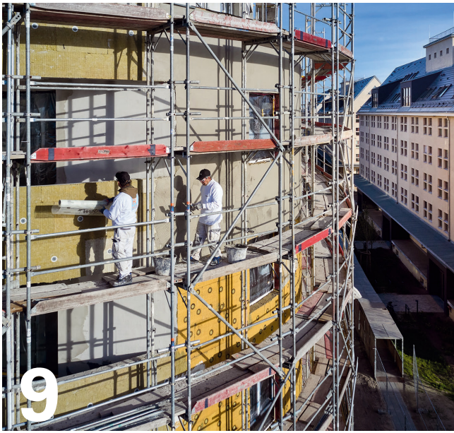
9 Das Wohnquartier Speicherballert der Buwog in Berlin Spandau wurde mit einem sortenrein trennbaren WDVS errichtet. Foto: Saint Gobain Weber
