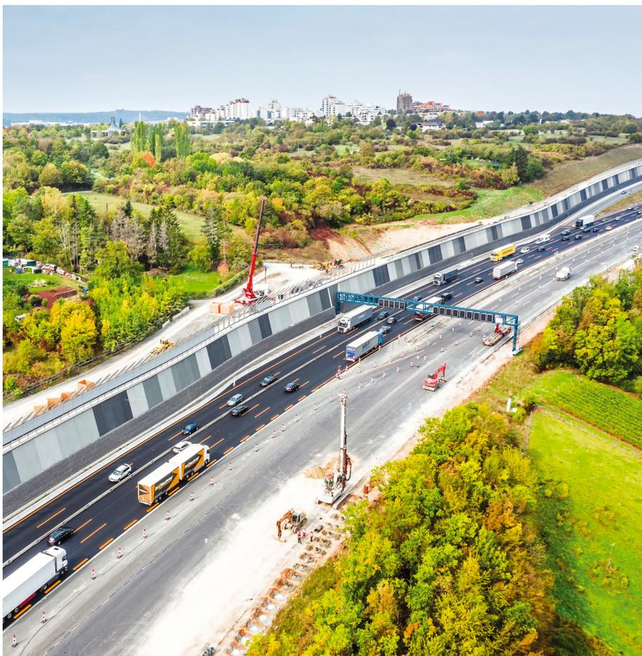
FCN lieferte Lärmschutzelemente aus haufwerksporigem Beton in verschiedenen Grautönen für die Autobahn A3 im Bereich von Würzburg Heidingsfeld. Foto: FCN, Tom Bauer, Würzburg; J1-Fotografie Jan R. Schäfer
