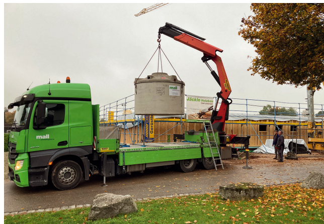
Bild 8. Lieferung des unterirdischen Regenspeichers PF 7600 aus Betonfertigteilen, mit integriertem Filterkorb im Zulauf und werkseitig vormontierten Wanddurchführungen für Zu- und Überlauf sowie einem Leerrohr als Verbindung zum Regencentre im Gebäude. Foto: Mall
