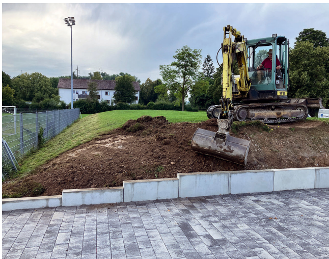
Bild 9. Verlegen der wasserdurchlässig befestigten, 650 m 2 großen Fläche vor dem Gebäude als Betonstein-Läuferverband, Fabrikat Kronimus Typ K4, Format 32/16 cm, 6 cm stark mit 5 mm Fugenbreite, Abflussbeiwert 0,3 – 0,4. Foto: Mall
