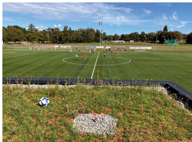
Bild 7. Im Vordergrund extensives Retentions-Gründach Sponge City Roof mit einem der Abläufe, ein halbes Jahr nach Fertigstellung. Die gewählte Samenmischung „Bienenweide“ hat das Potential, auch ohne Bewässerung gut zu verdunsten und Trockenphasen gut zu überstehen. Foto: Mall
