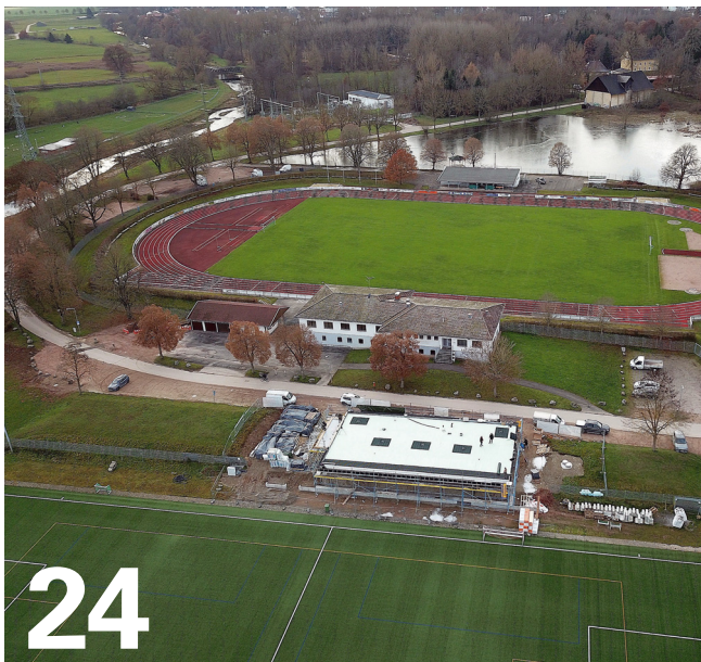
Sportanlage Im Haberfeld, Donaueschingen. Neubau des Vereinsheims SSC unten im Bild, mit weißer Dachabdichtung, vor dem Aufbau des Retentions Gründachs Sponge City Roof. Foto: Mall
