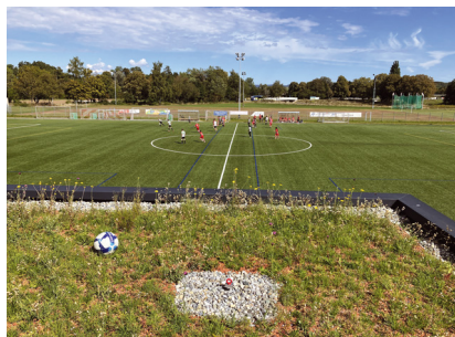
Im Vordergrund: Gründach mit einem der Abläufe, ein halbes Jahr nach Fertigstellung. Die gewählte Samenmischung „Bienenweide“ hat das Potenzial, auch ohne Bewässerung gut zu verdunsten und Trockenphasen gut zu überstehen. Foto: Mall
