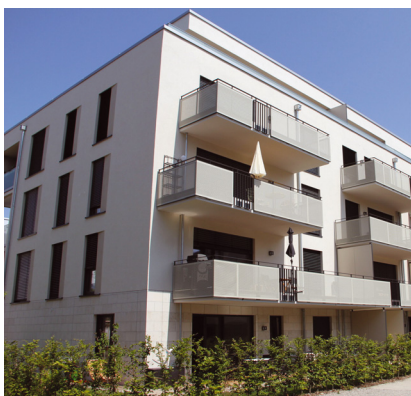
In diesem Wohnhaus in der Max-Bill-Straße im Münchener Stadtquartier Domagkpark werden jeden Tag rund 3\ 000\ \text{l} Grauwasser aus Duschen, Badewannen und Handwaschbecken aus 32 Wohneinheiten für die WC-Spülung und die Grünflächenbewässerung aufbereitet. Foto: Intewa
