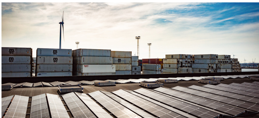
Jährlich 223 t CO 2 spart MSC MedRepair in Antwerpen mit den „Vertex S“-Hochleistungsmodulen von Trina Solar ein. Foto: Trina Solar/Eoluz
