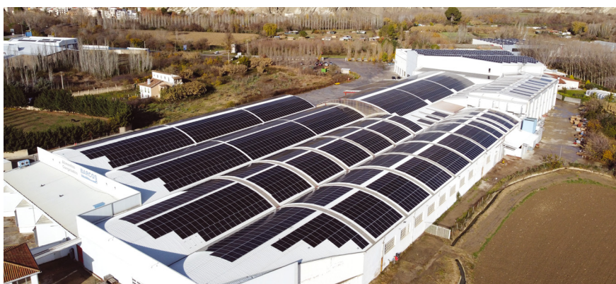
Industrie-Photovoltaik-Anlage mit „Vertex“-Doppelglasmodulen von Trina Solar beim spanischen Tiefkühlwarenanbieter Barcos in der Region Navarra (Projektpartner Alba Renova). Foto: Trina Solar/Alba Renova
