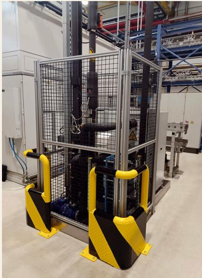
**Bild 2.** Durch die Integration der Wärmepumpe mit Plattenwärmetauscher ist der Stromverbrauch deutlich gesunken. Die sehr kompakte Installation erhitzt das Prozesswasser durch ein spezielles technisches Verfahren auf bis zu 65 °C. Foto: Ecoclean
