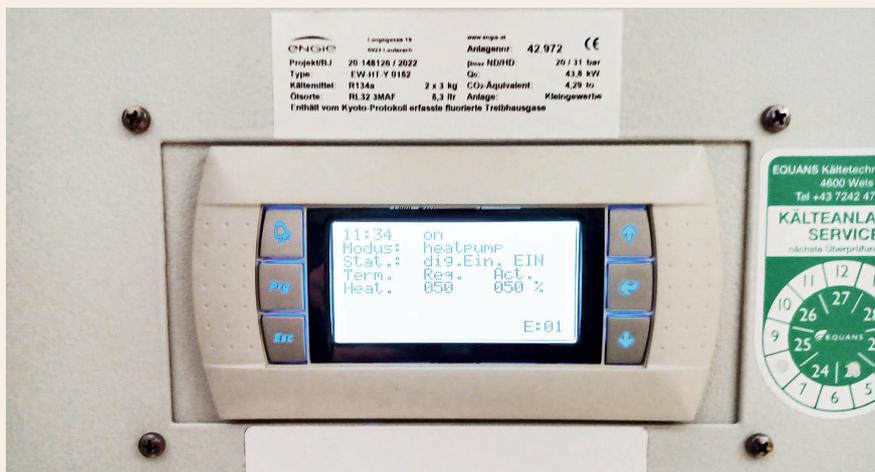
**Bild 1.** Zur Kontrolle von Temperatur und Durchfluss wurde die neue, Energie sparende Wärmepumpe beim Automobilhersteller am Standort Steyr/A mit einem Display ausgestattet. Foto: Ecoclean
